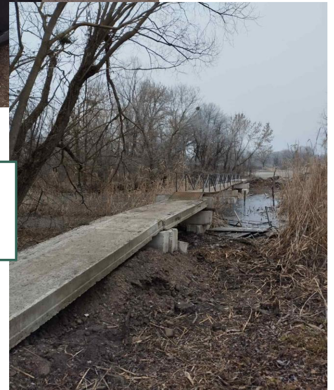
Ремонт пішохідного містка через .р.Хорол с. Сергіївка
